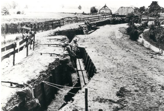
Infanterieopstelling met loopgraven achter het Valleikanaal
