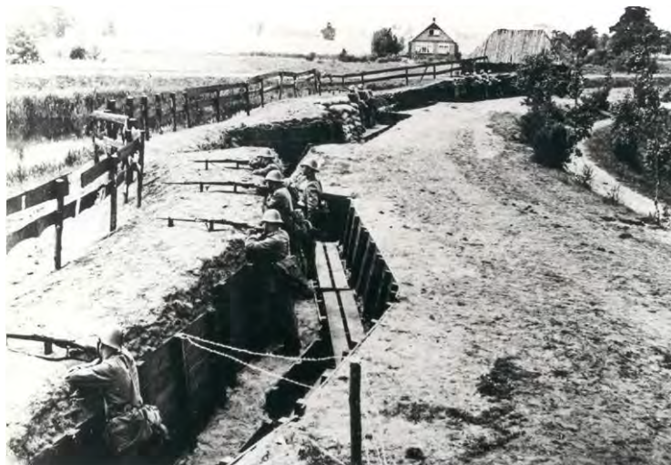
Infanterieopstelling met loopgraven achter het Valleikanaal
