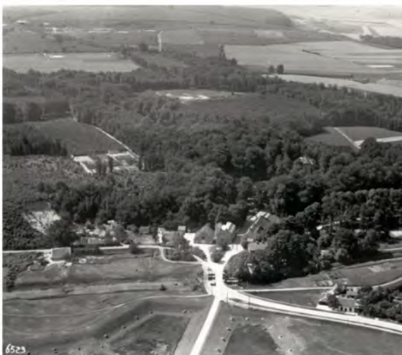
Gezicht op de Oostelijke helling van de Grebbeberg met de Grebbesluis. (1929)
